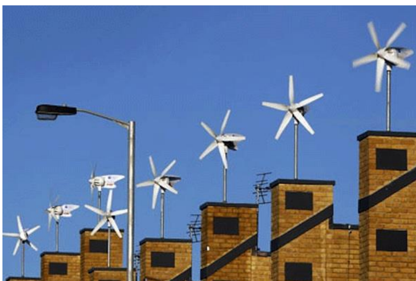
Ilustración 13: instalación minieólica.
